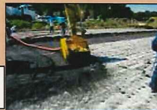
固化剤を用いた削り取り
